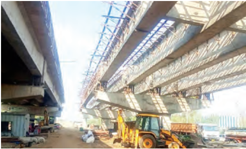
फ्लाईओवर का 40% काम बचा हुआ है। एनएचआइ के अधिकारियों के उदासीन रवैयें के कारण निर्माण
